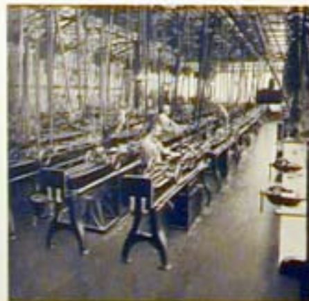
FORAGE DES CANONS DE FUSILS
