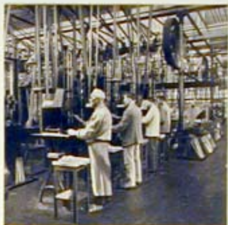
POLISSAGE INTÉRIEUR DES CANONS DE FUSILS
