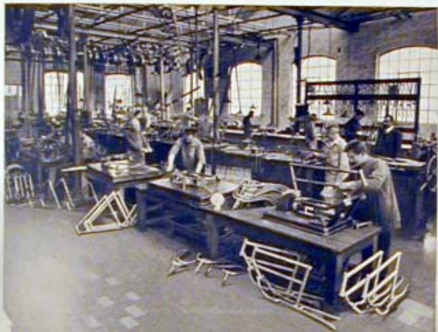
FABRICATION DES CADRES VÉLOS MOTOS
